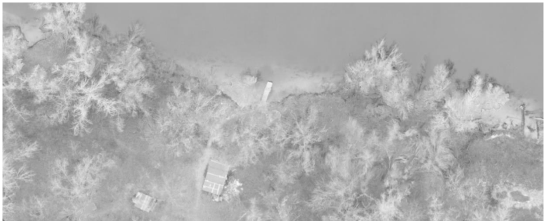
Рис. 4 Причал, будівля та відокремлений блок
